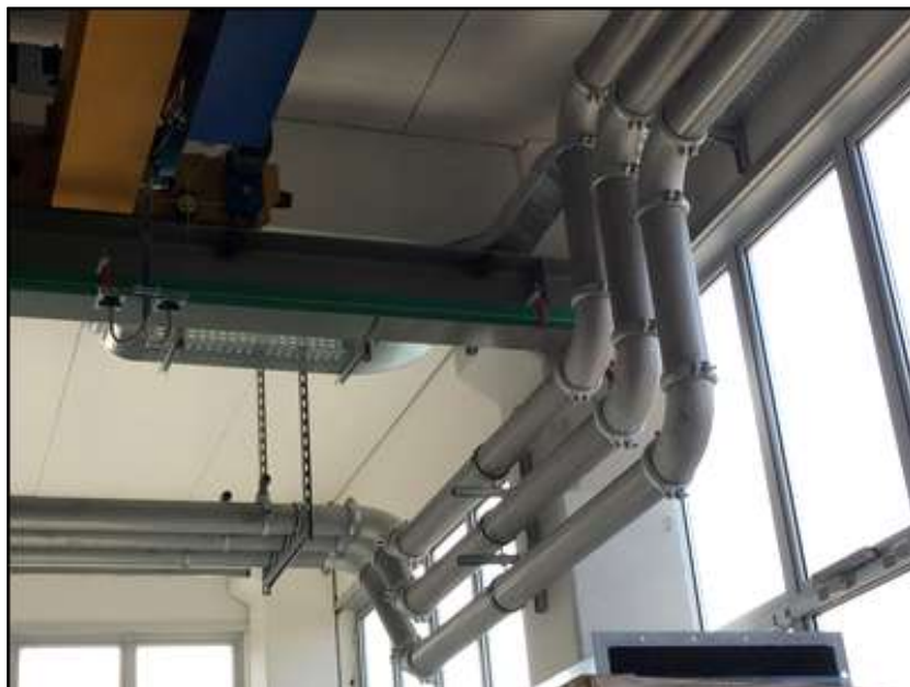
Acqua refrigerata Aria compressa DN150
