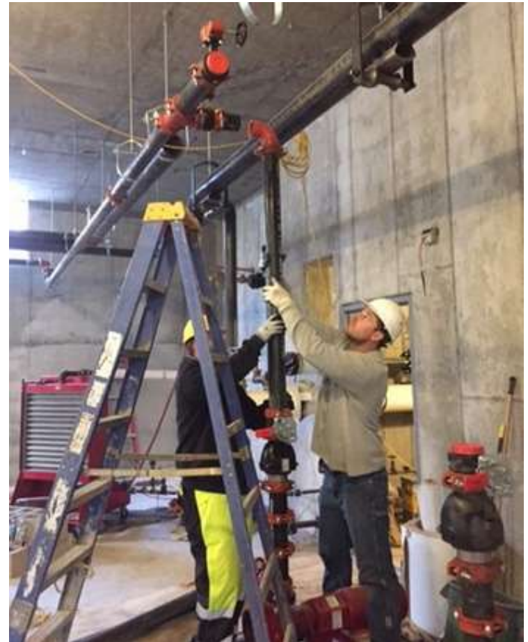
Installazione degli assiemi
