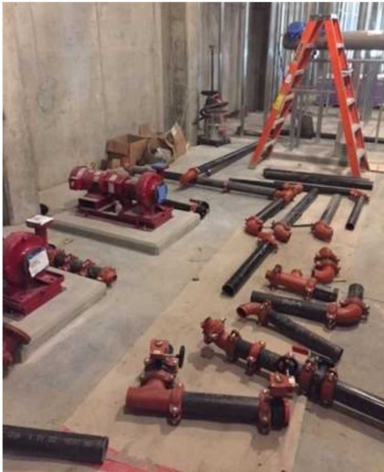
Ricezione elementi prefabbricati
